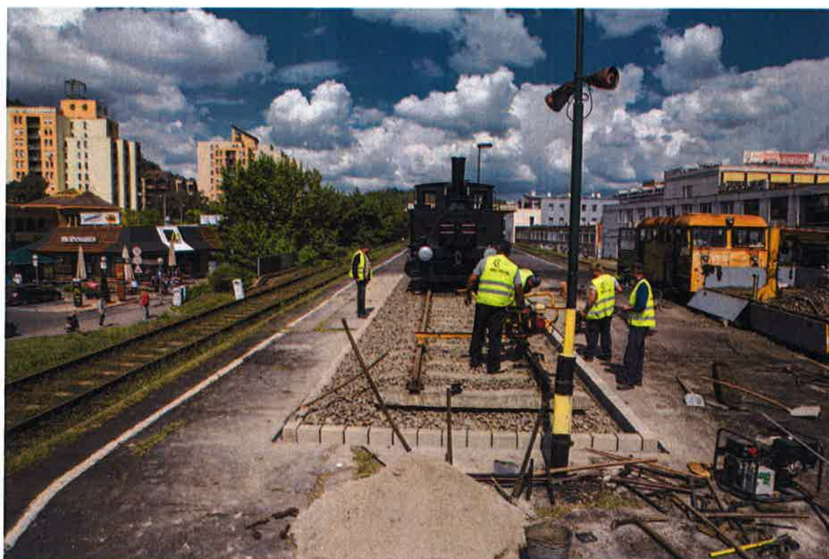
A mozdony kiállítási helyének előkészítése
